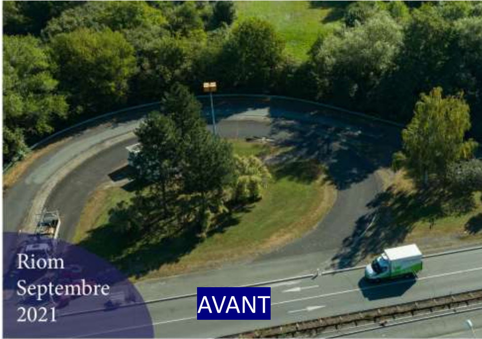
Route départementale RD 2029
